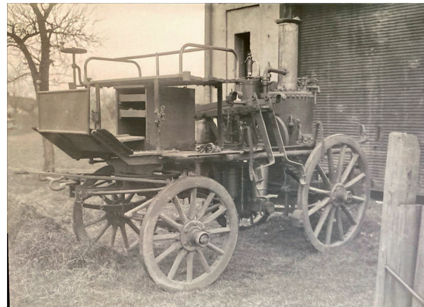
Obrázek 77 Čtyřkolová motorová stříkačka na koňský potah od firmy Richard Herold Chomutov
